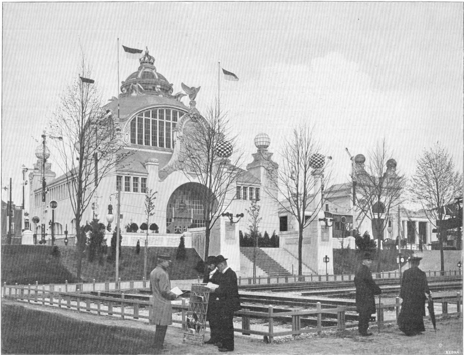
Pavillon der Kgl. Eisenbahndirectionen
