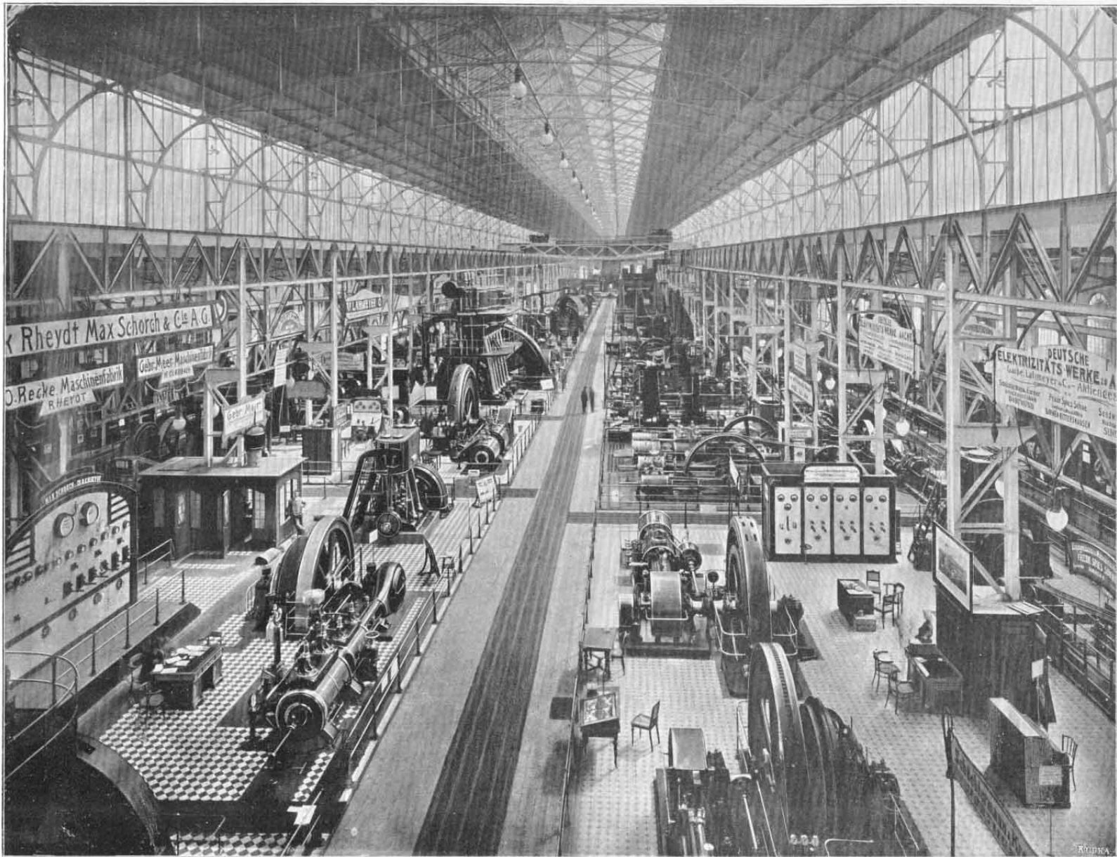
Inneres der Maschinenhalle: Gesamtansicht.
