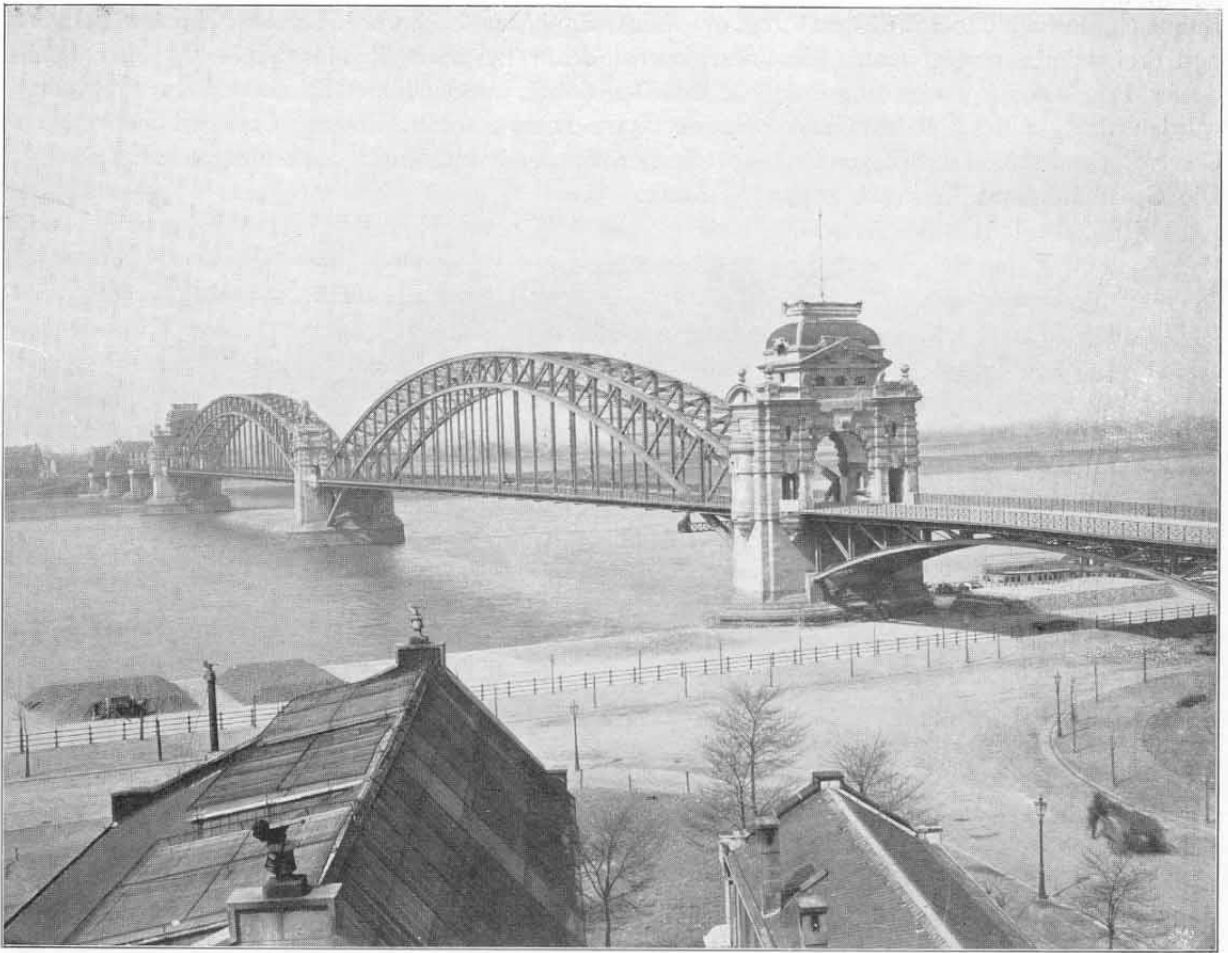
Abb. 164. Ansicht der in den Jahren 1896 bis 1898 erbauten Strassenbrücke bei Düsseldorf.
