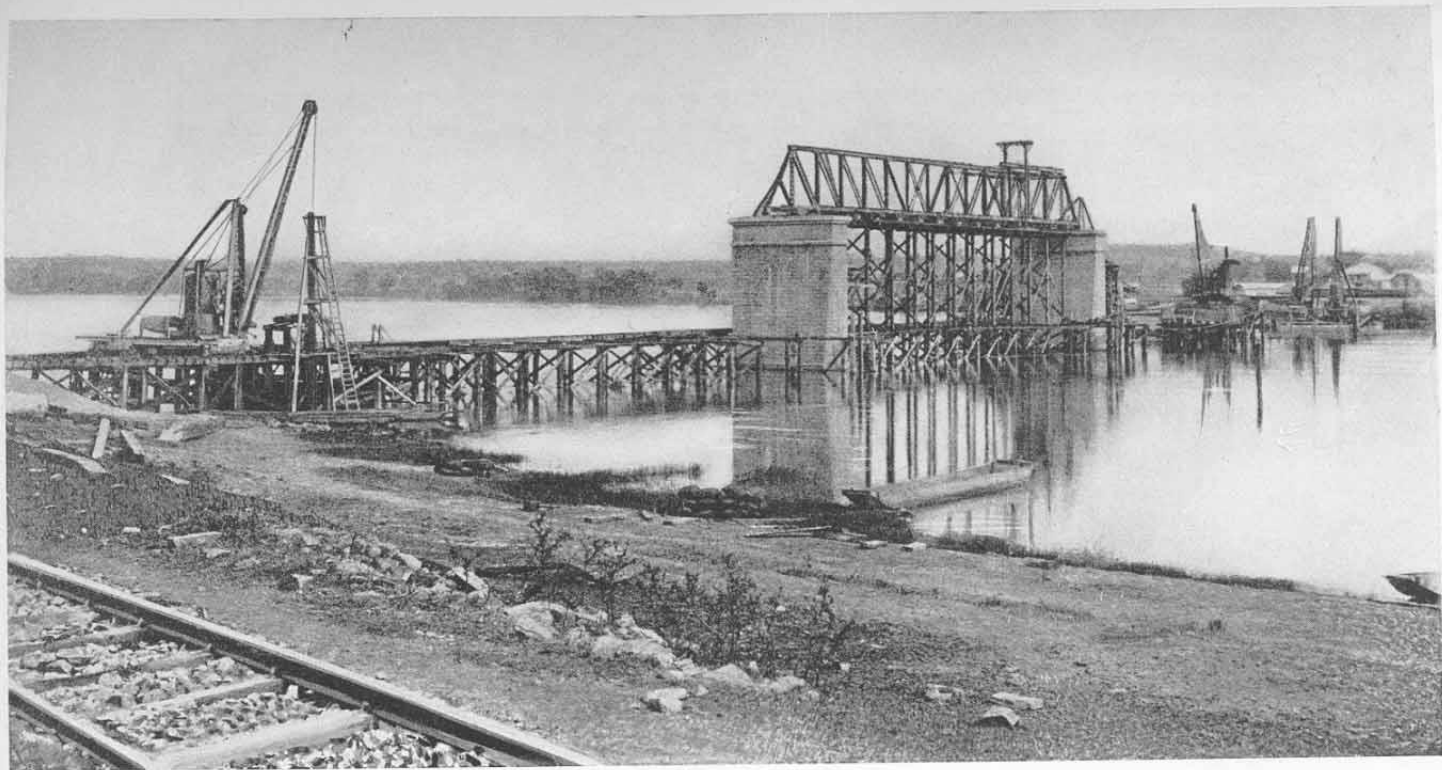
Abb. 60. Brückenbau der Nigerischen Bahn am Niger bei Jebba; Südarm. Stand am 1. März 1913. Blick nach Osten.
