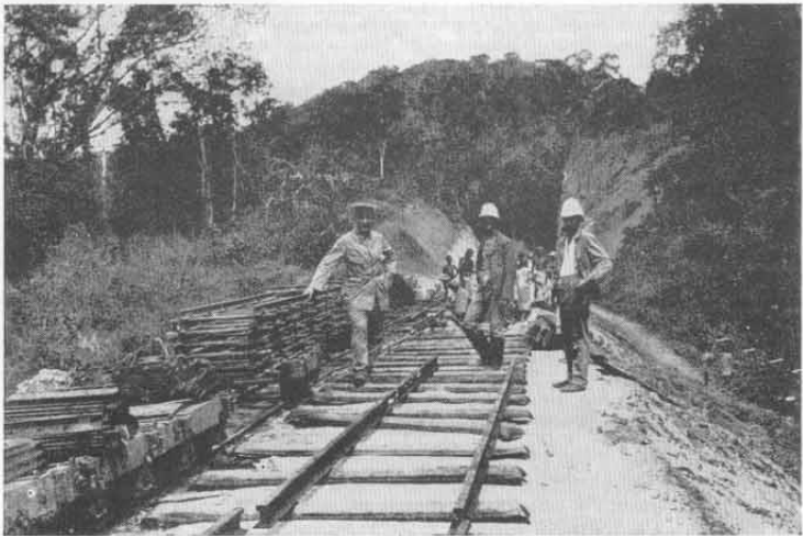
Abb. 91. Tanganjikabahn. Vorarbeiten des Oberbaues.
