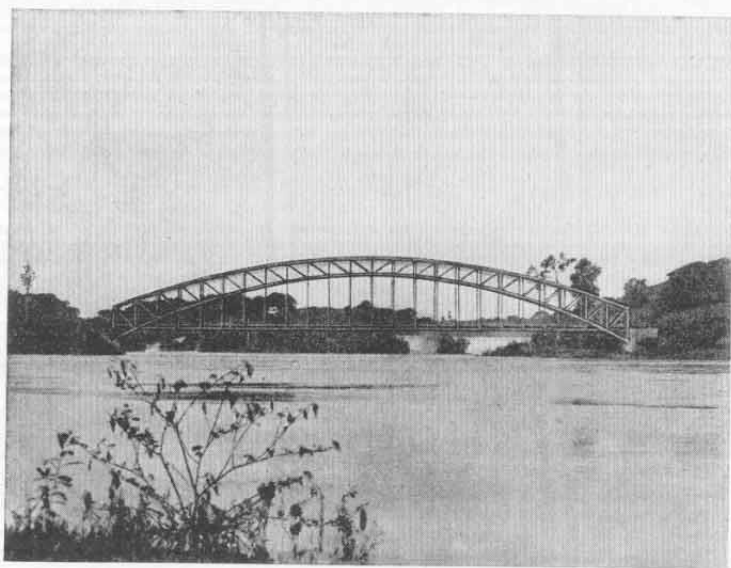
Abb. 31. Sanaga-Südarmsbrücke mit den Fällen des Sanaga.
