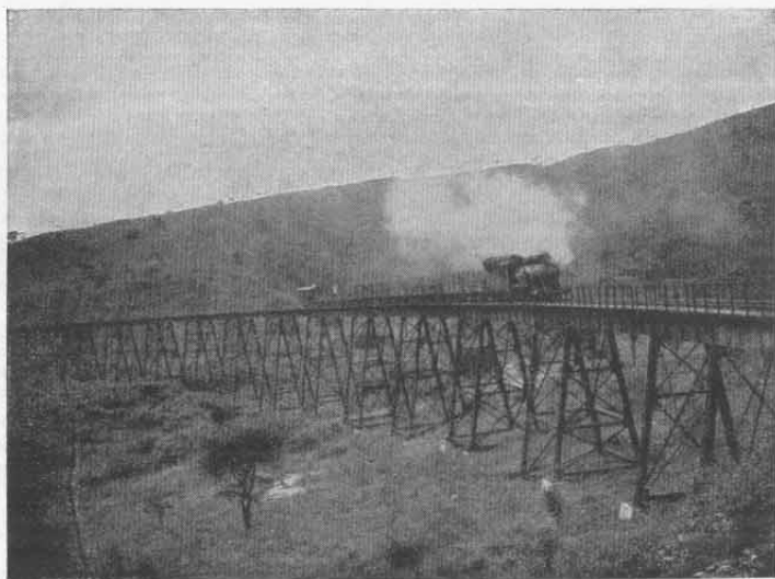
Abb. 106. Gerüstbrücke bei Fort Ternan.
