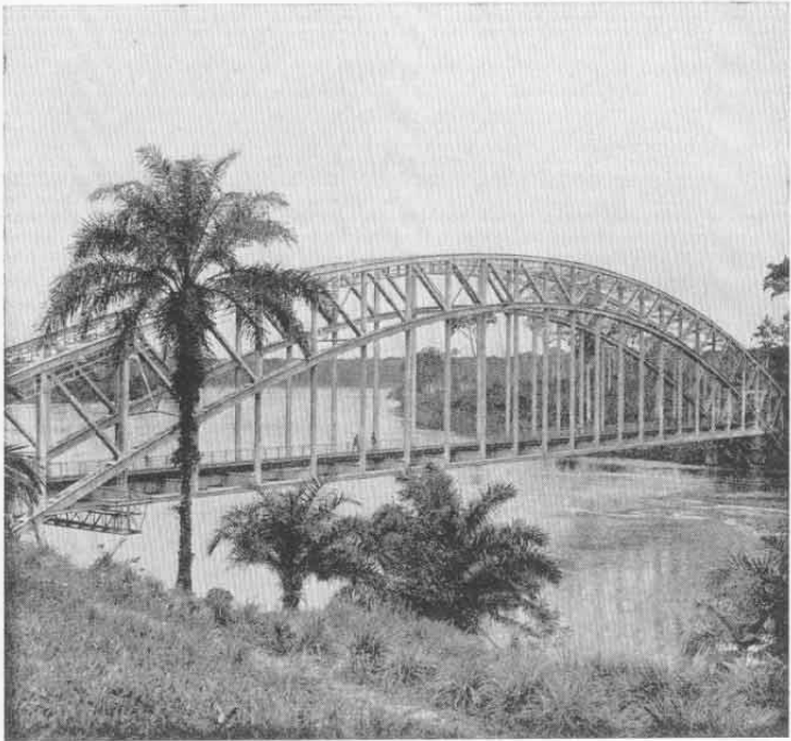
Abb. 29. Kameruner Mittellandbahn. Brücke über den Sanaga-Südarm.
