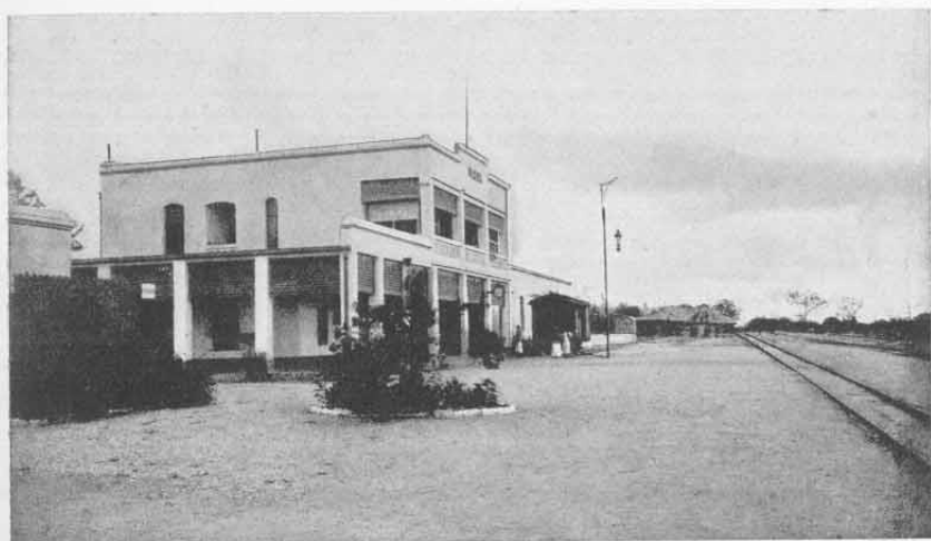
Abb. 17. Bahnhof Kilossa der Tanganjikabahn.
