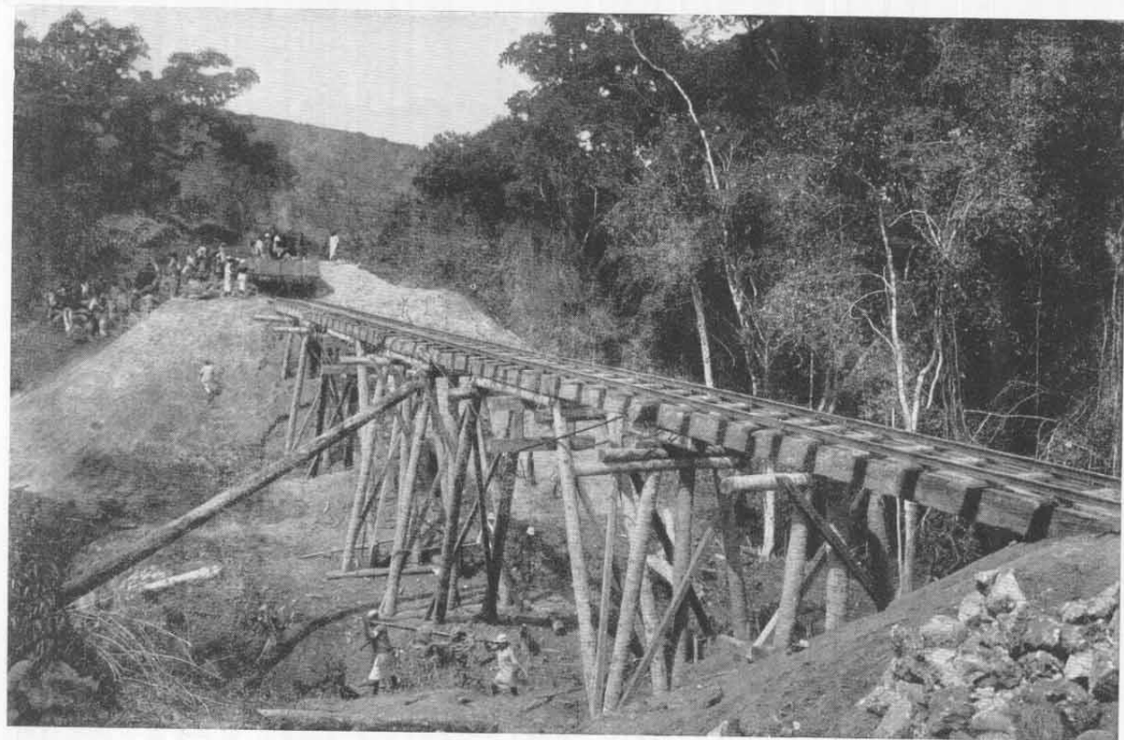
Abb. 86. Erdarbeiten und Gleisprovisorien in den Pugubergen (Tanganjikabahn).
