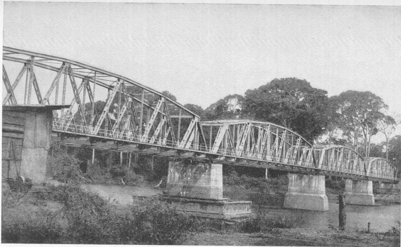
Abb. 28. Brücke über den Sanaga-Nordarm im Zuge der Kameruner Mittellandbahn.
