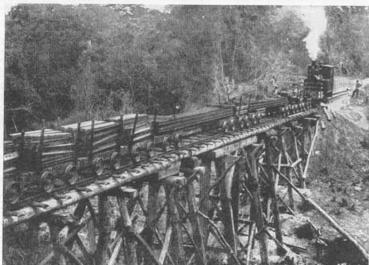
Abb. 90. Tanganjikabahn. Oberbauzug auf einer vorläufigen Holzbrücke.
