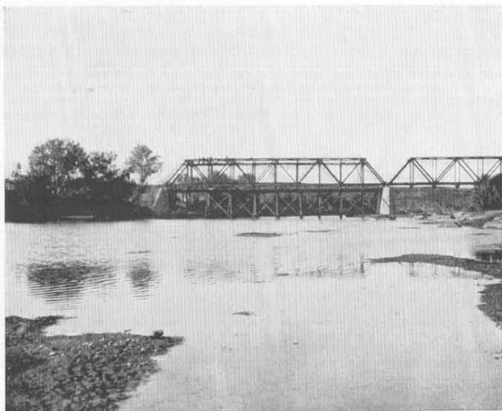
Abb. 34. Bau der Fischflußbrücke im Zuge der Eisenbahn Lüderitzbucht—Keetmanshoop.
