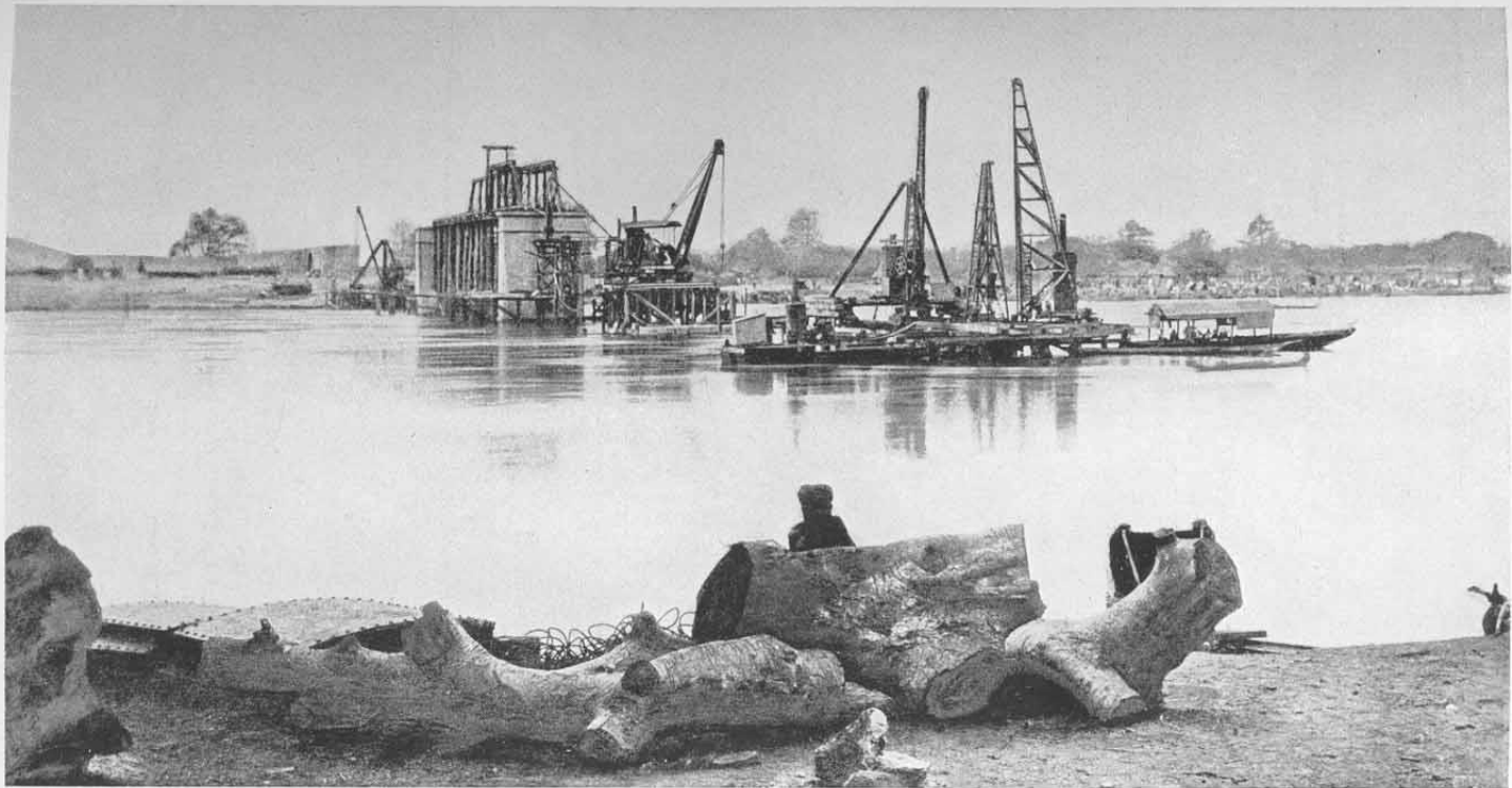
Abb. 61. Brückenbau der Nigerischen Bahn am Niger bei Jebba; Südarm. Stand am 1. März 1913.
