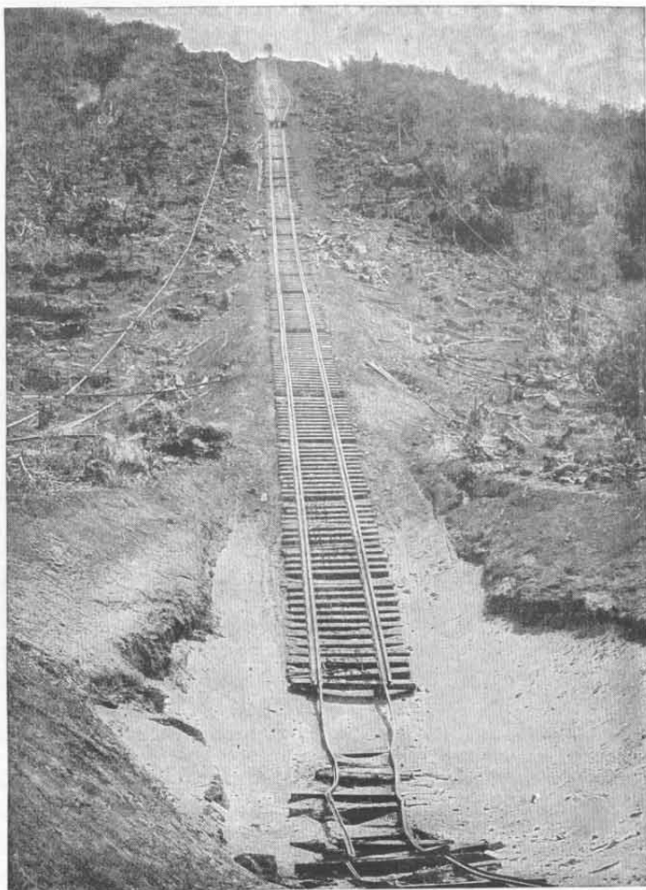
Abb. 95. Bremsberg im Kikuyu-Gebirge. Dritter Abschnitt.
