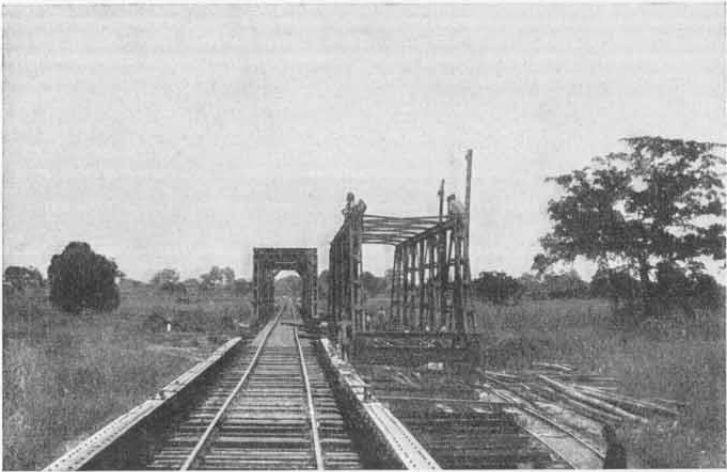
Abb. 18. Tanganjikabahn. Auswechslung eiserner Überbauten.
