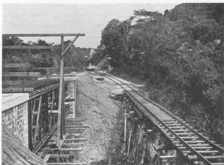
Abb 92. Tanganjikabahn. Umfahren eines Bauwerkes durch eine vorläufige Brücke.
