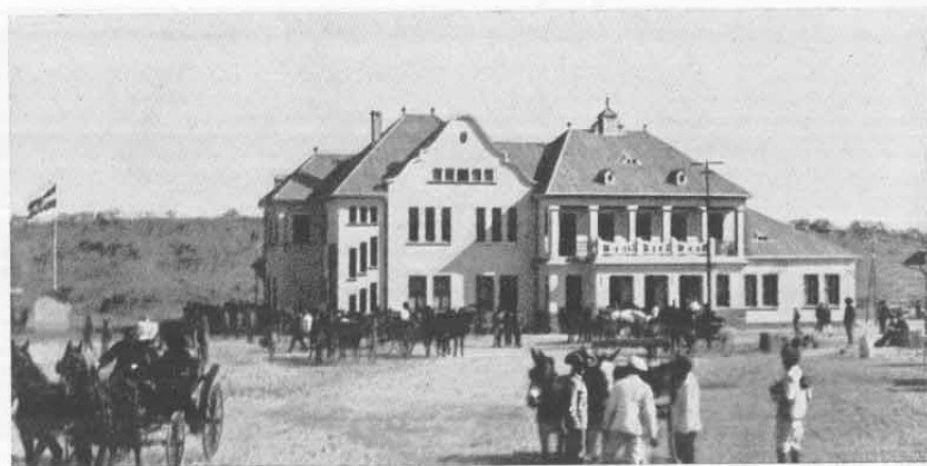
Abb. 121. Stationshaus auf Bahnhof Windhuk.
