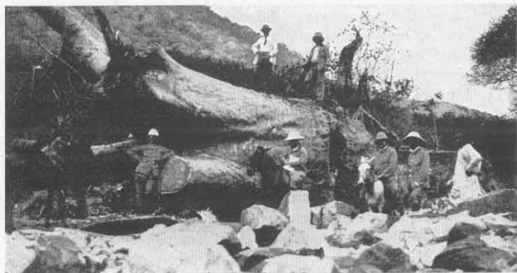
Abb. 87. Sprengen von Baum-Riesen mit Dynamit. Bahnbau Morogoro—Tabora.
