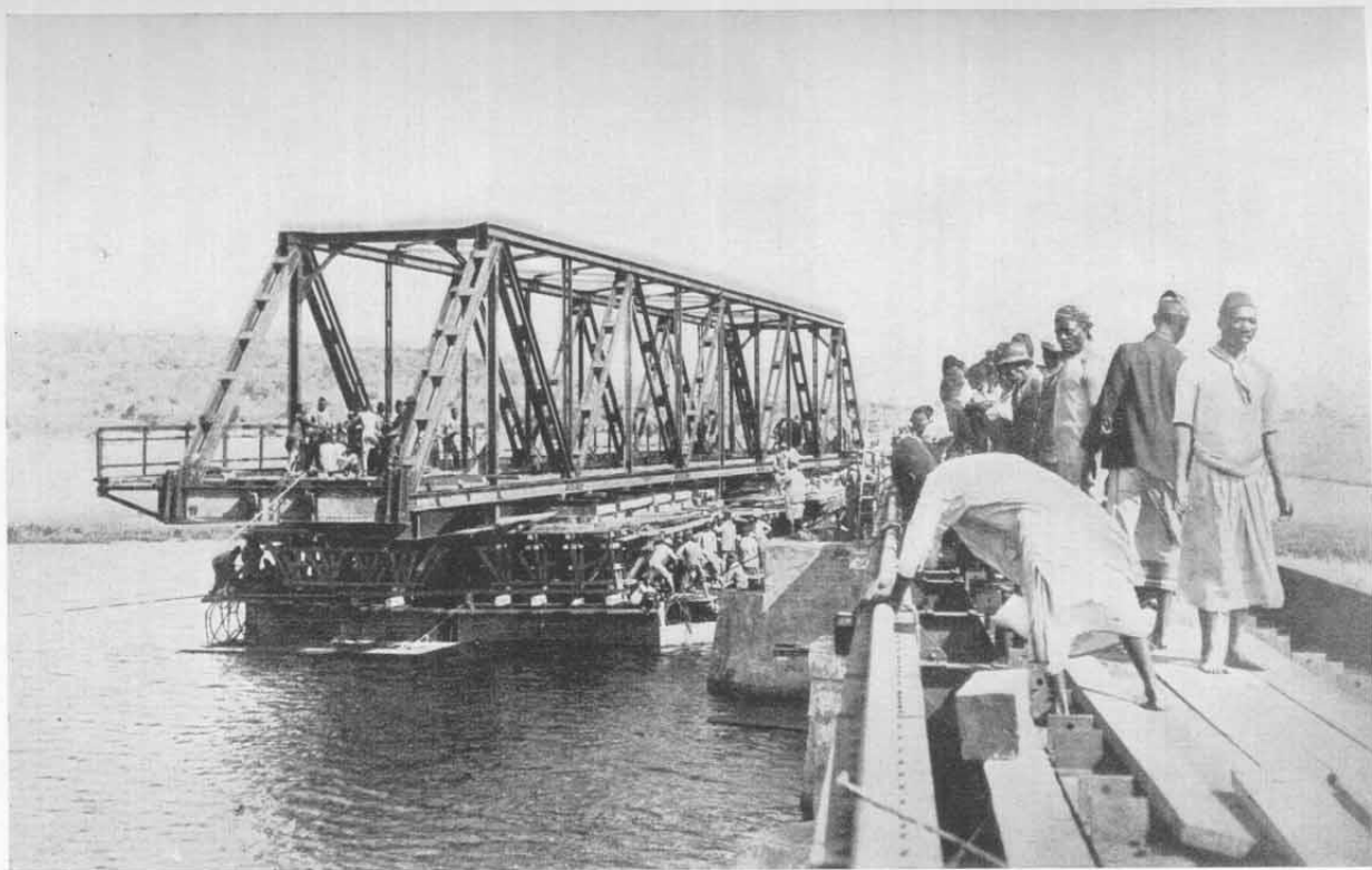
Abb. 20. Brücke über den Malagarassi. Einschwimmen des eisernen Überbaus der Hauptöffnung.
