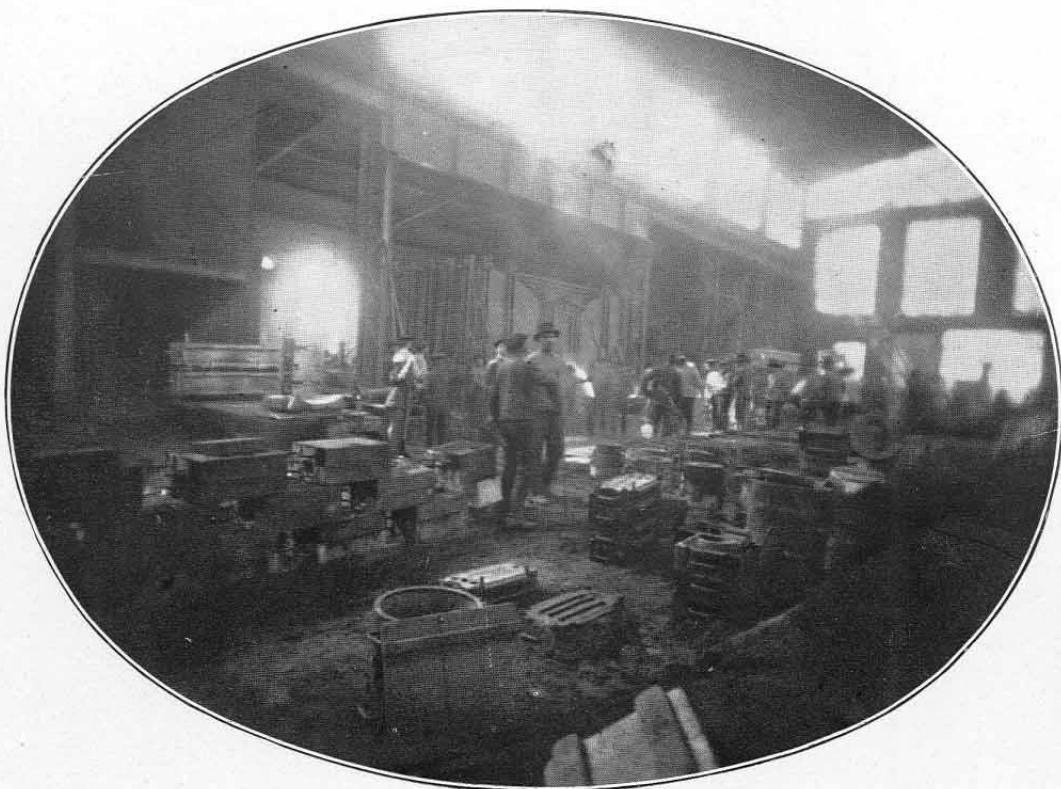
Kgl Hüttenamt Gleiwitz — Abstich eines Martinofens (Stahlgießerei)
