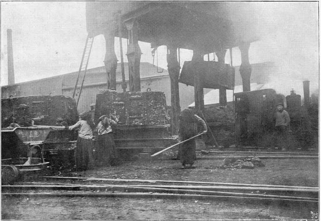
Abb. 2. Abheben der Stahlhauben von den erstarrten Thomasschlackenblöcken
