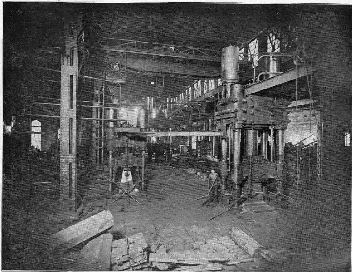
Abb. 9. Gesamtansicht des Preßwerks in Gleiwitz
