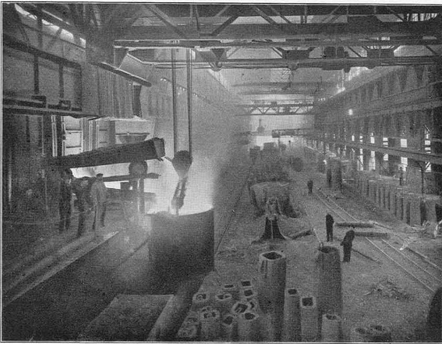
Stahlwerk der Julienhütte — Abstich
