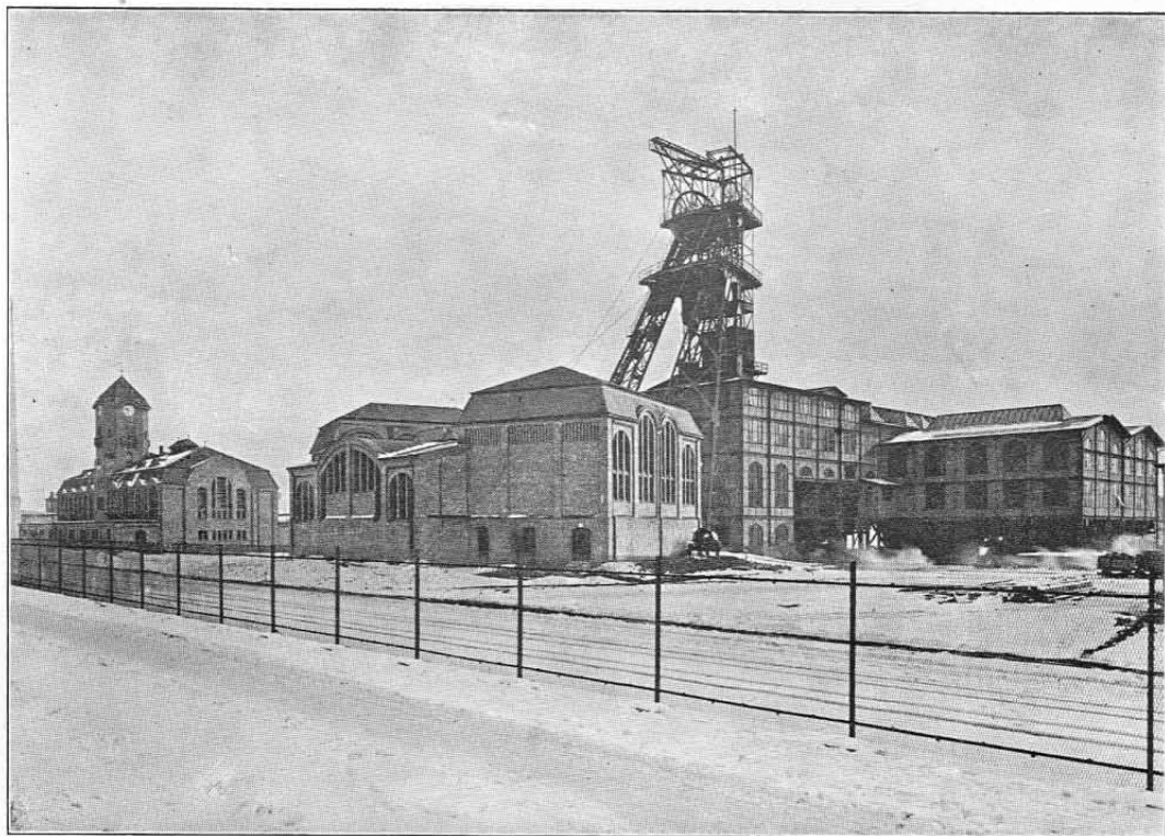
Carmerschacht der cons. Giesche- und Reservegrube
