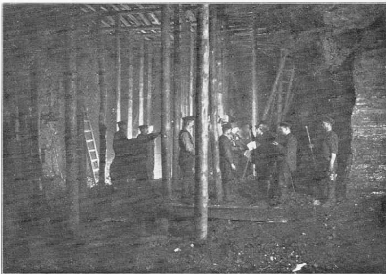
Gedingestellung im Pfeilerabbau
