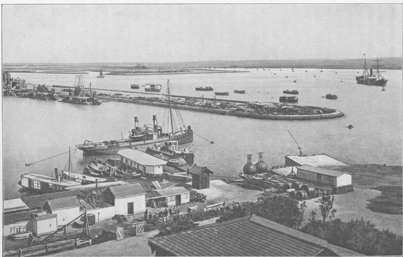
Einfahrt in den Suezkanal bei Port Tewfik.
