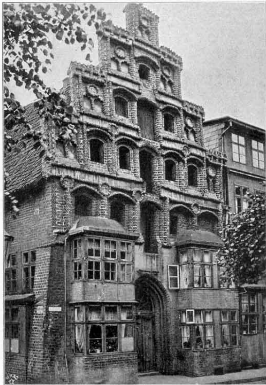
Abb. 92. Giebelhaus in der Lünentorstraße zu Lüneburg. (Zu Seite 75.)
