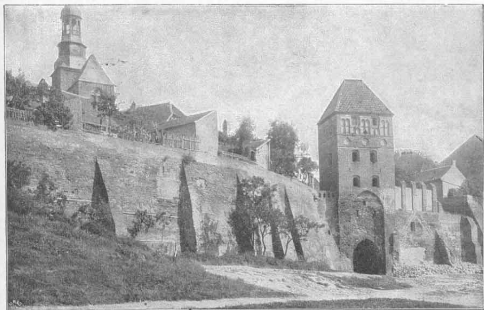
Abb. 23. Stadimauer zu Tangermünde. Nach einer Photographie von F. Albert Schwarz in Berlin. (Zu Seite 28.)
