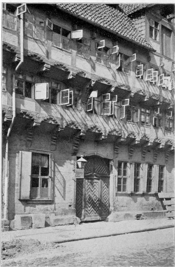
Abb. 90. Haus mit Holzschnitzereien in Hildesheim. Nach einer Photographie von F. Albert Schwarz in Berlin.
