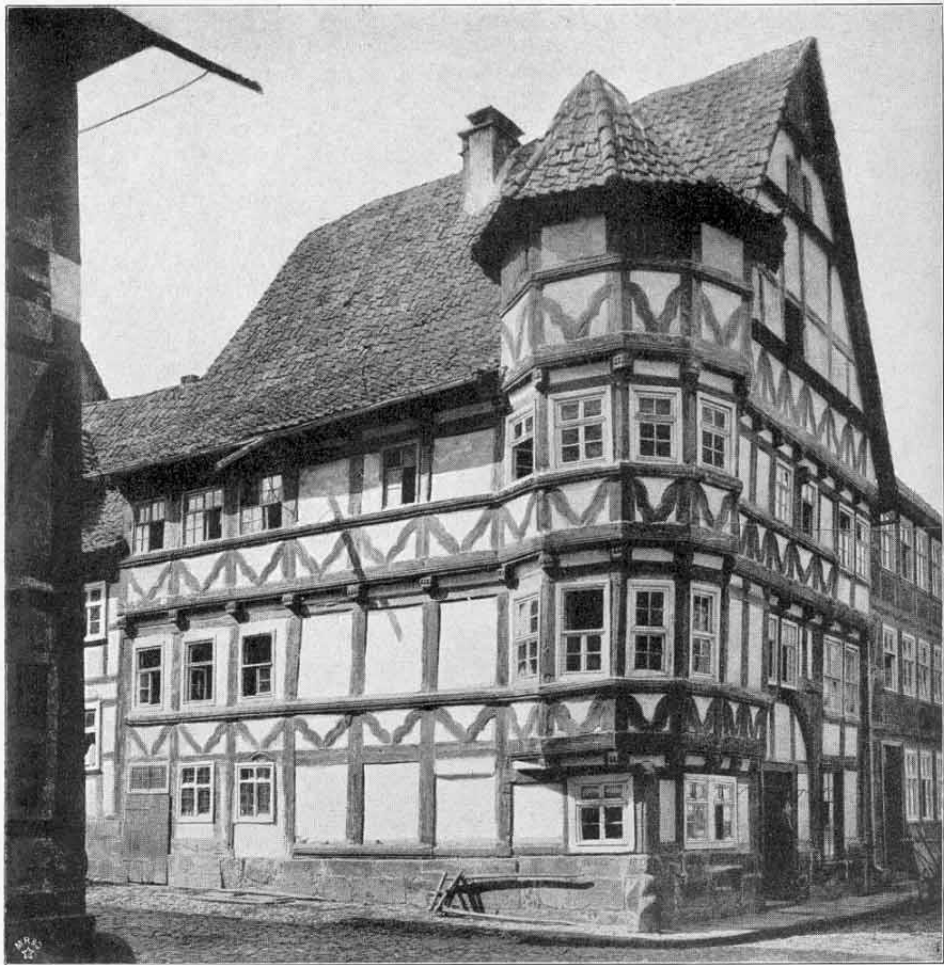
Abb. 95. Haus in der Ermschwerderstraße Nr. 125 in Wigenhausen. Aus Bidell „Hessische Holzbauten“, N. G. Ewert'sche Verlagsbuchhandlung in Marburg i. S. (Zu Seite 74.)
