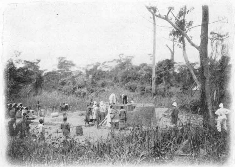
Bau eines Kalkofens in Stanleyville.
