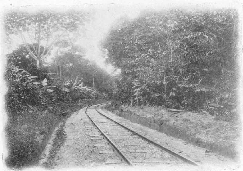
Ansicht der Bahn bei km 8.
