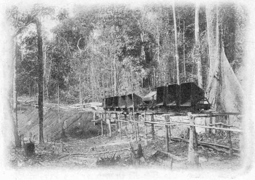
Dammbau bei km 77.
