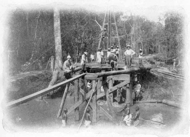
Pfehlgerüst der Uluko-Brücke (km 71).
