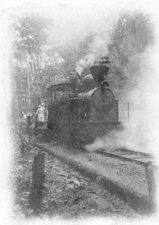
Betriebslokomotive (18 tons), einen Materialzug befördernd.
