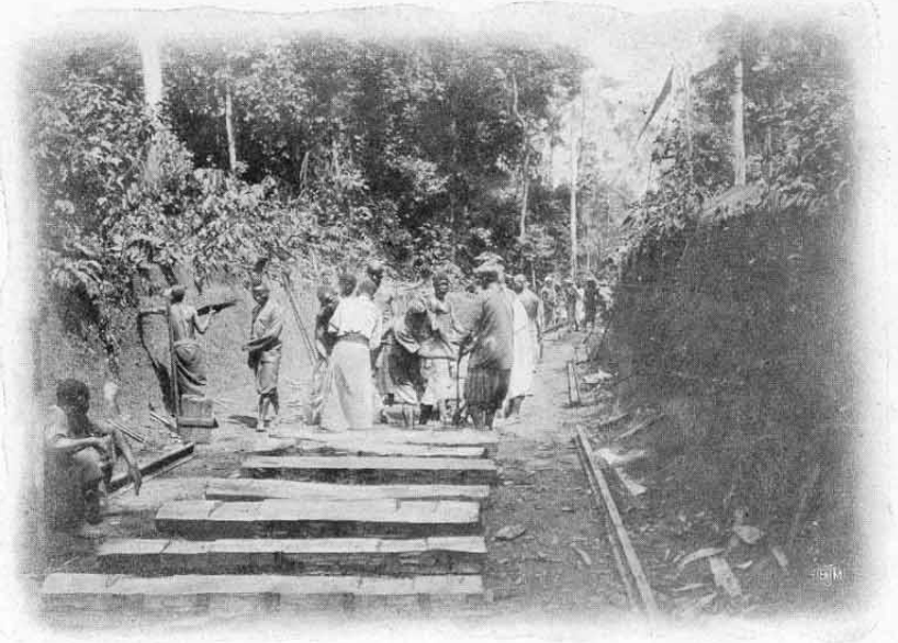
Legen und Bohren der Schwellen.
