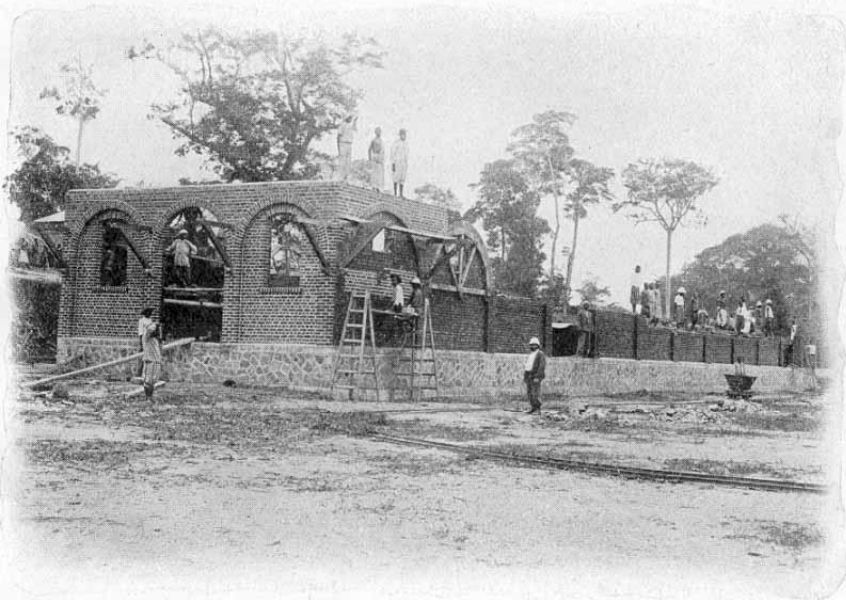
Stanleyville. — Bau eines Magazins.
