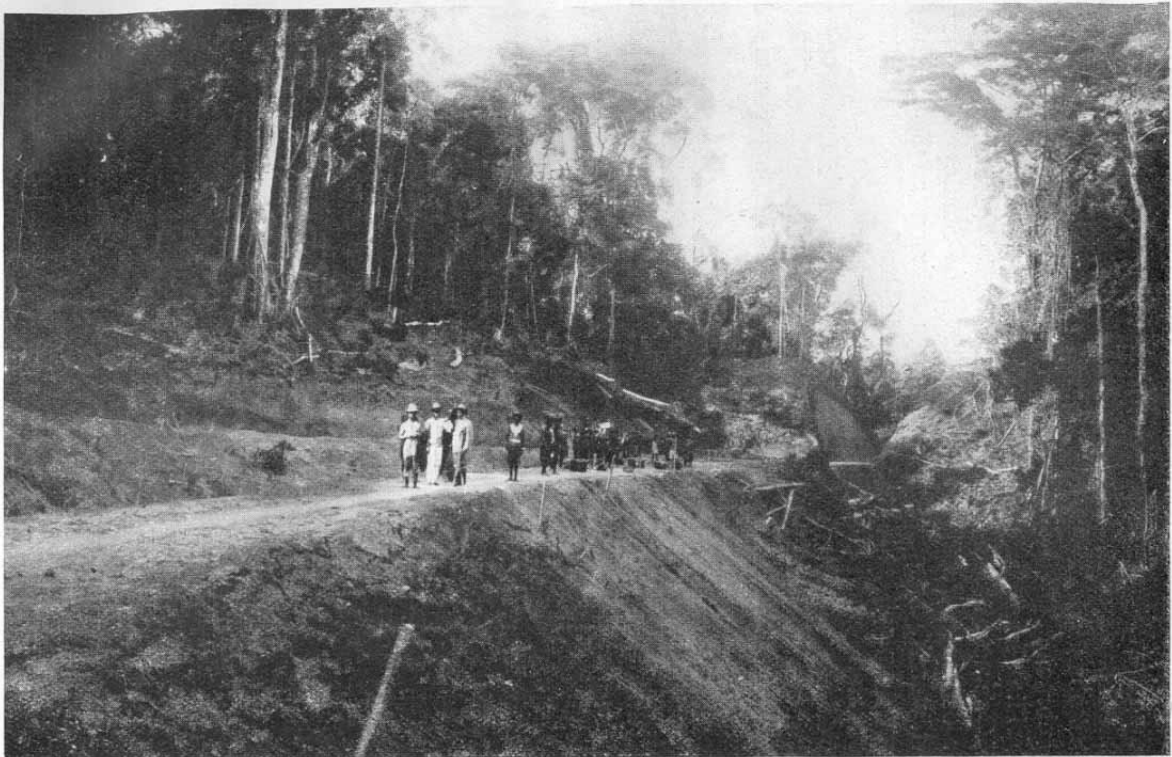
Erdarbeiten bei km 117—118.
