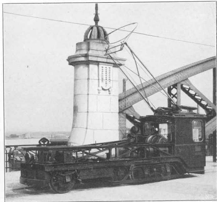
Fig. 28. Treidellokomotive 1905/06 für den Betrieb am Teltowkanal.
