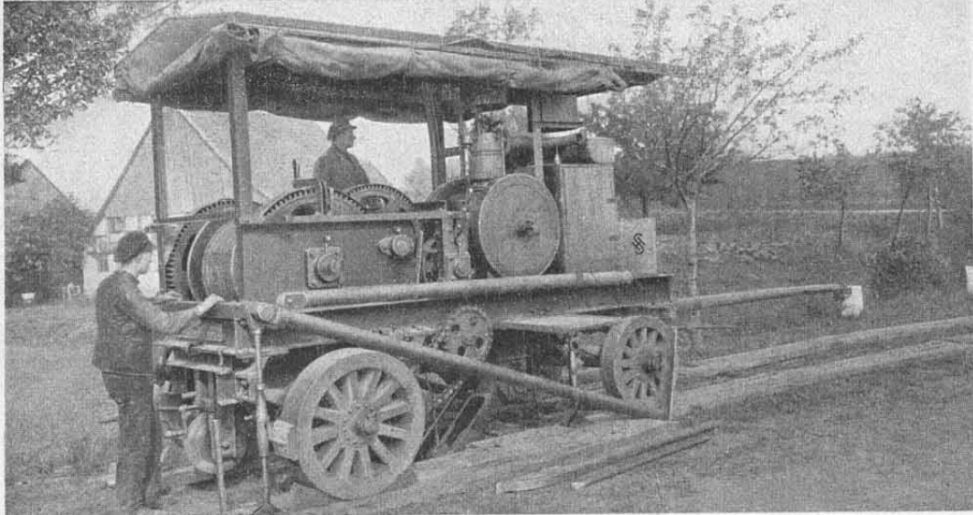
Abb. 6. Kabelwinde im Betrieb.
