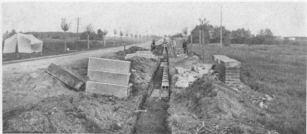
Abb. 1. Bau des Zementkanals.
