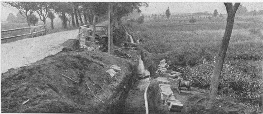
Abb. 3. Verlegung eines Erdtabels auf Schwellenrost.
