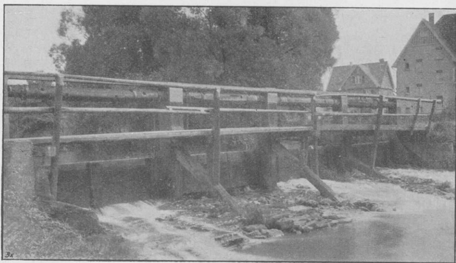
Abb. 1. Übersfallschleusenwehr in der Sieg unmittelbar oberhalb der Einmündung des Ferndorfbaches.
