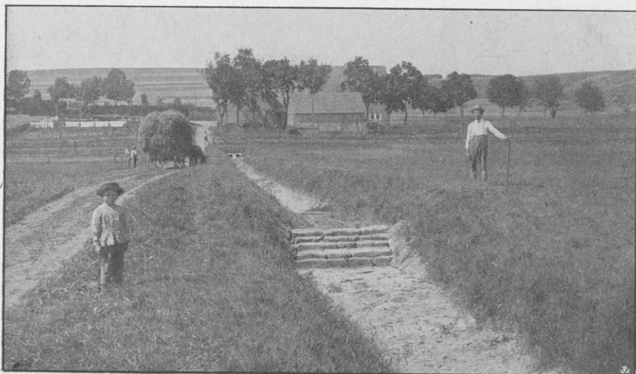
Abb. 12. Zuleiter mit Sohlenabfall.
