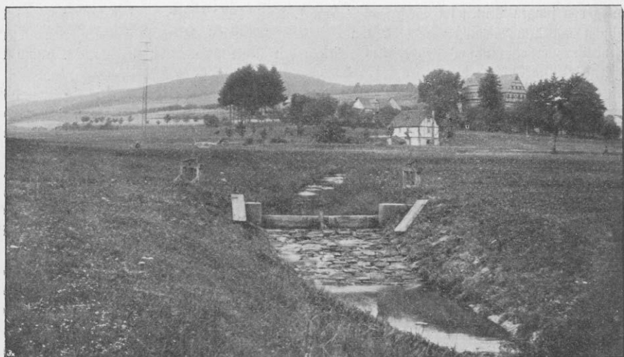
Abb. 9. Wehr aus Pflasterung und Werkstücken im Heesbache bei Zunkernhees.
