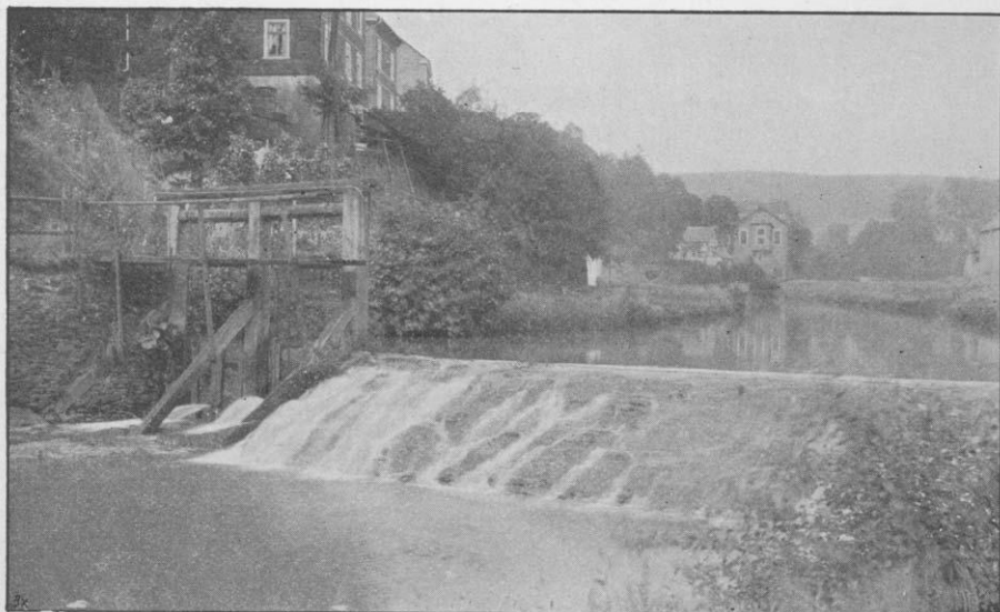
Abb. 2. Übersfallswehr mit Grundschleuse im Ferndorfbache unmittelbar oberhalb der Einmündung in die Sieg.
