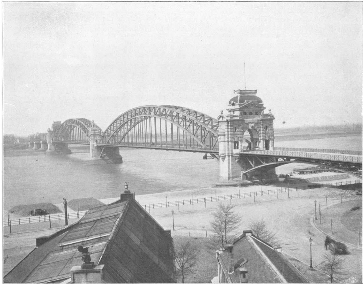
Abb. 80. Ansicht der in den Jahren 1896 bis 1898 erbauten Strassenbrücke bei Düsseldorf.
