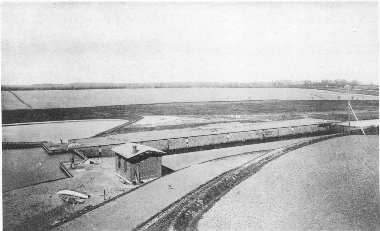
Krummehammer Schleuse mit Sparkammer.
