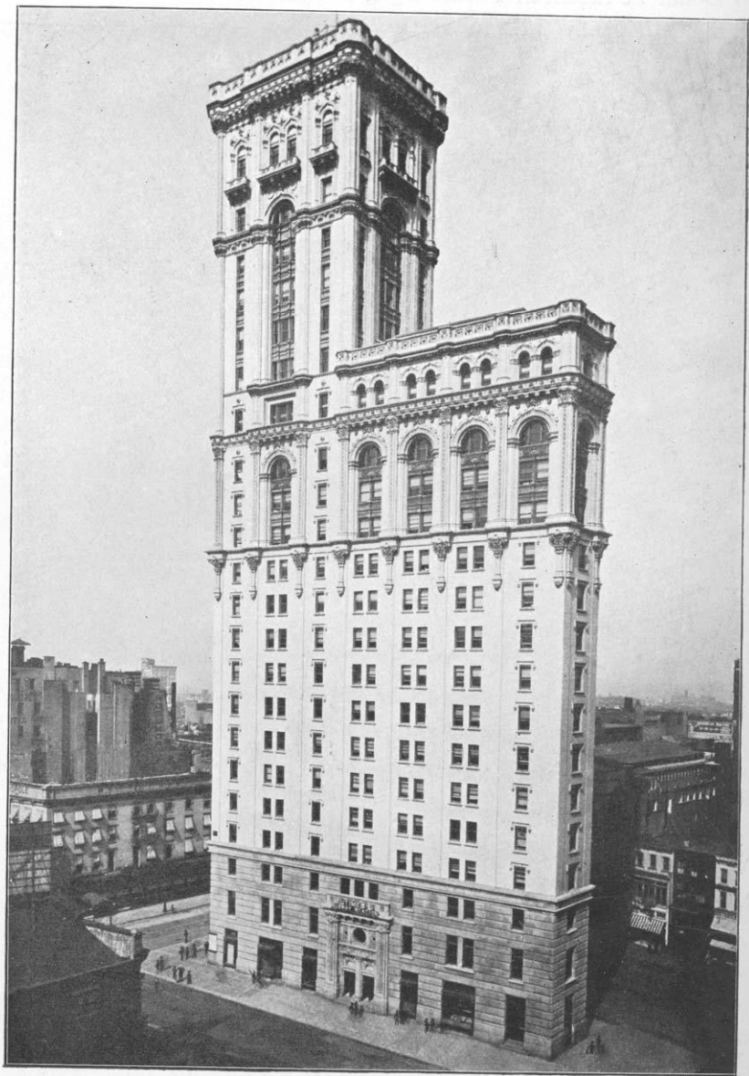
Das Gebäude der „Times“ in New York.
