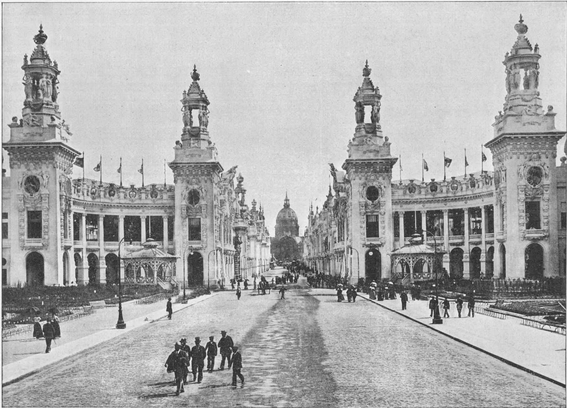
INVALIDES. — ENTRÉE DE L'AVENUE DE L'ESPLANADE.
