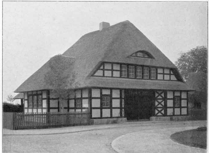
Abb. 35. Bahnhof Dahlem-Dorf. Arch. Gebr. Hennings.
