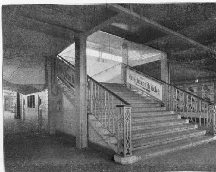
Abb. 6. Unterer Bahnsteig des Bahnhofs Gleisdreieck.
