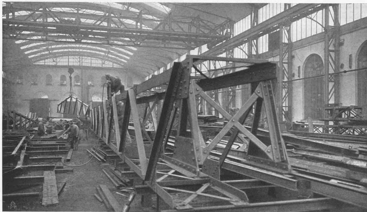
NIETHALLE FÜR EISENKONSTRUKTIONEN 90×30 m
