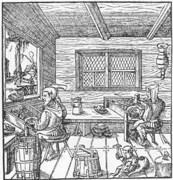
Abb. 26. Scheidung der Erze mit dem Fäustel.
