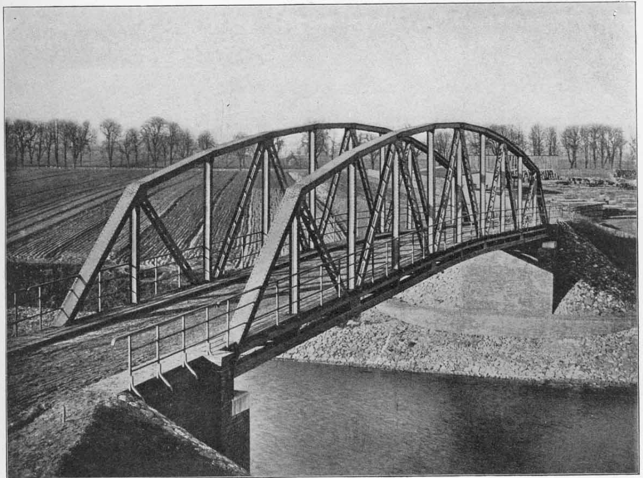
Strassenbrücke über den Durchstich Criewen-Schwedt.
