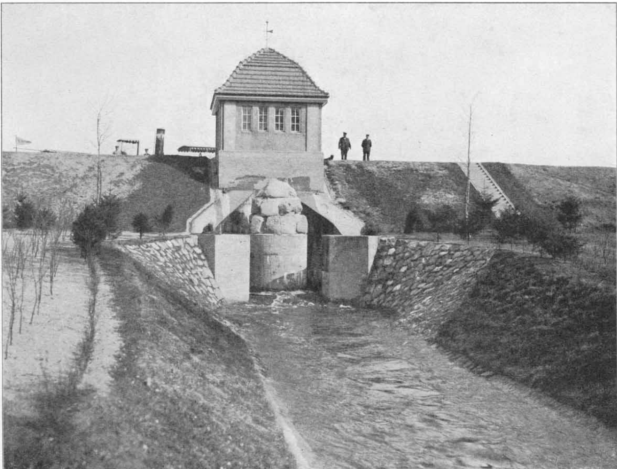
Kanalablass (Heber) am Mäckersee.
