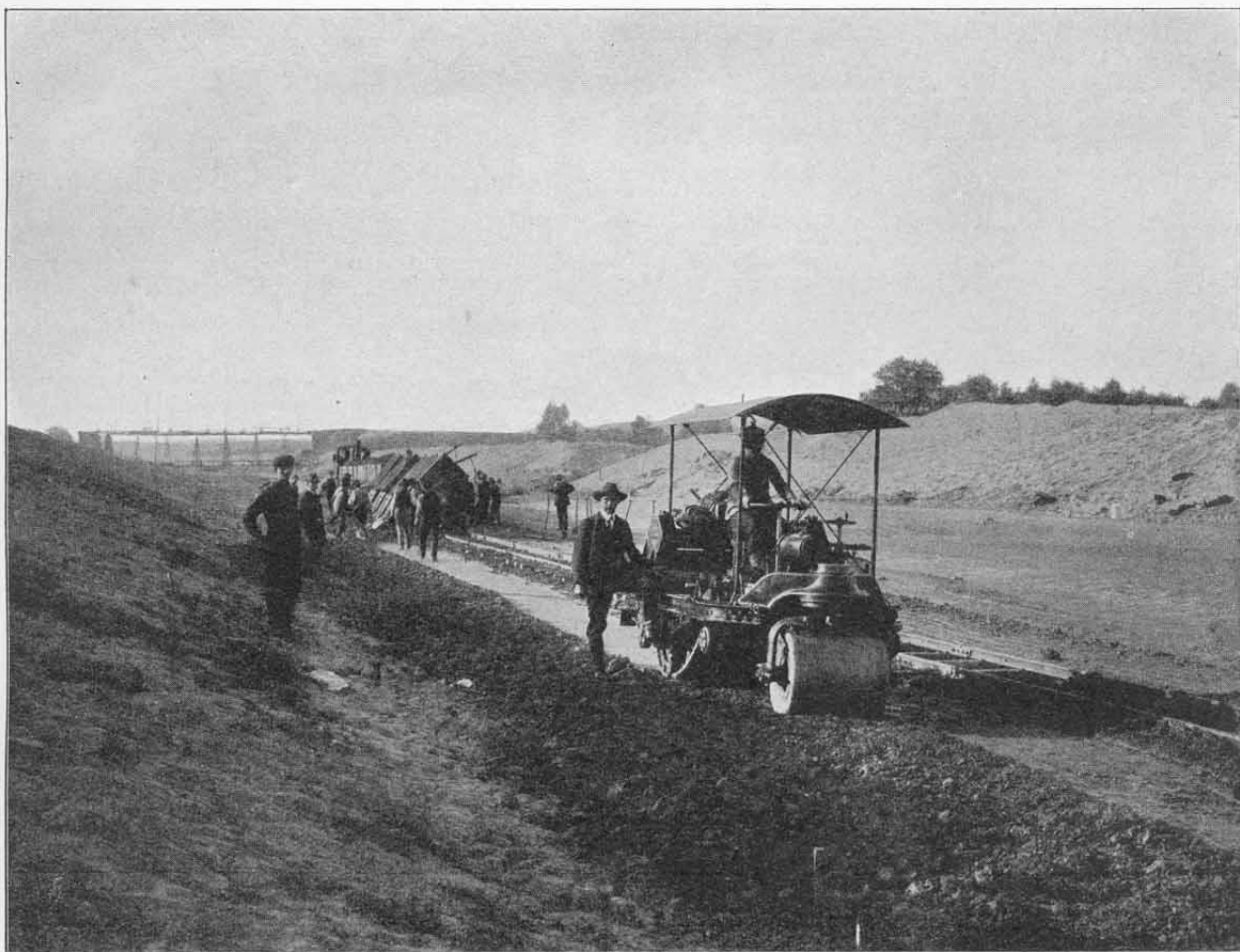
Motorwalze im Betrieb bei Herstellung der Tondichtung.
