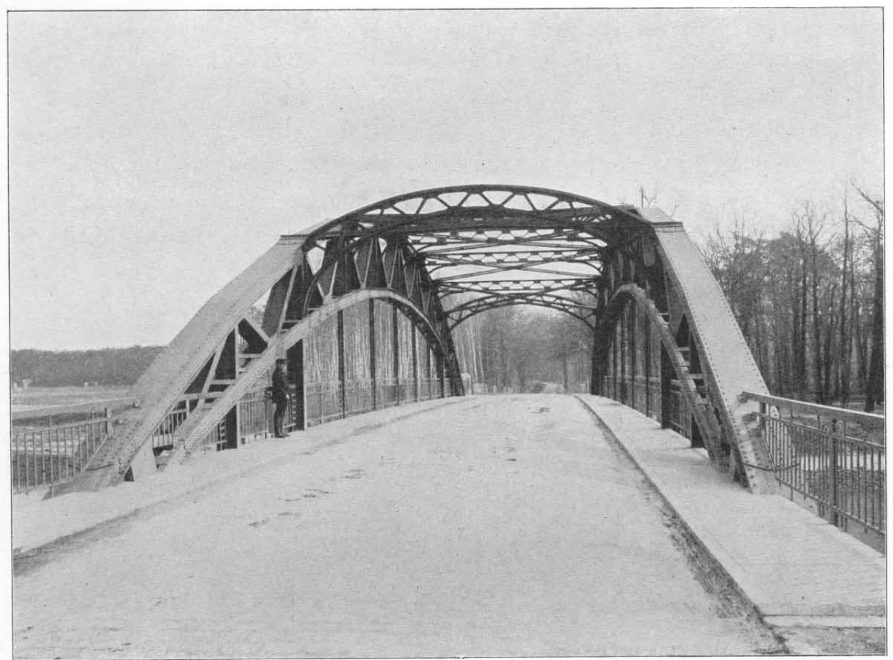
Lehnitzer Schleusenbrücke. Innenansicht.
