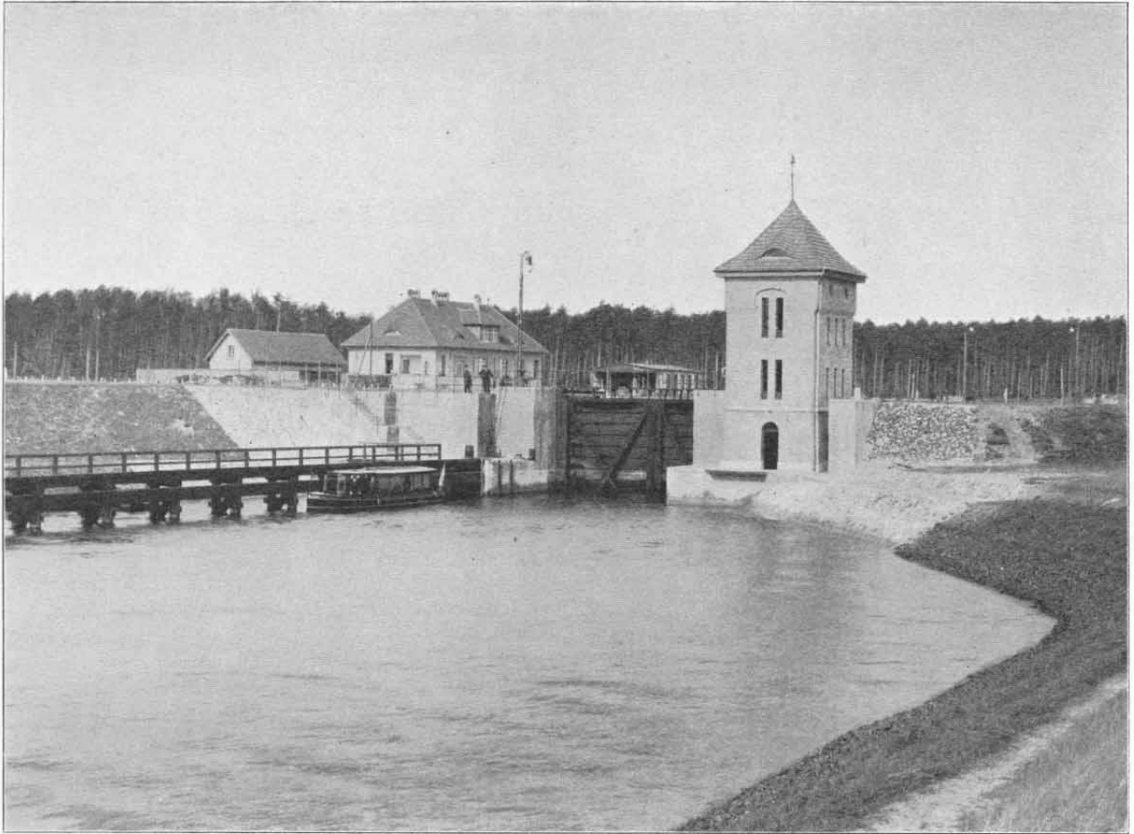
Lehnitz-Schleuse vom Unterwasser.
