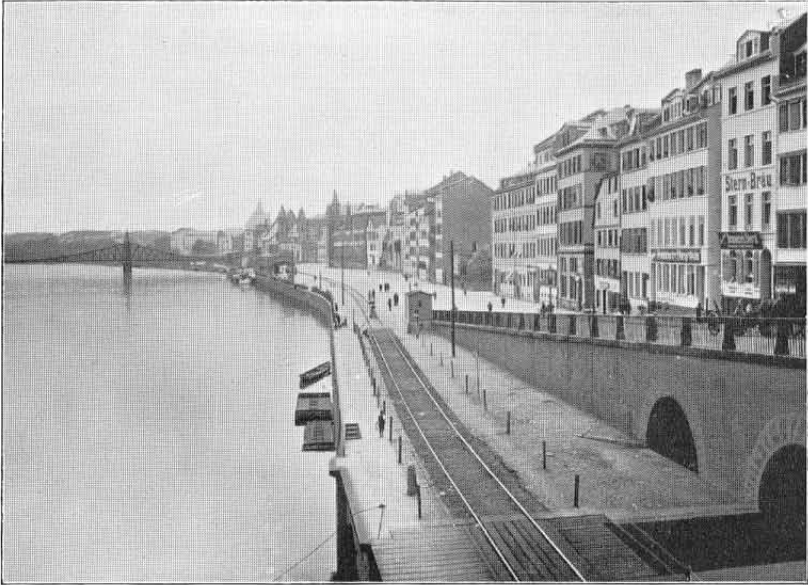
Mainkai unterhalb der Alten Brücke.
