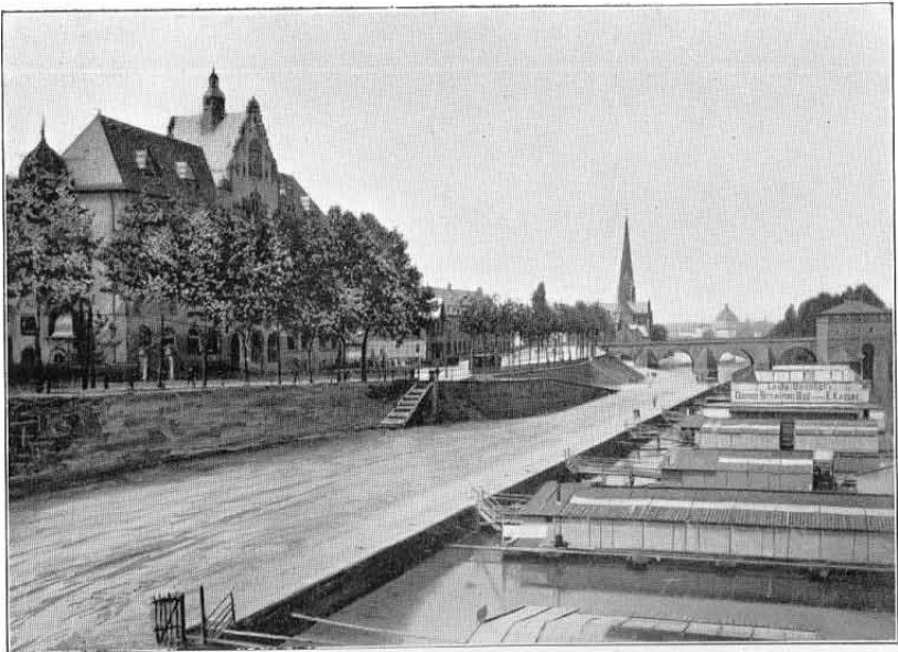
Deutschherrnkai unterhalb der Obermainbrücke.
