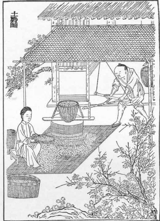
Fig. 36. Enthülsungs-Maschine (»Erd-Maschine«).
