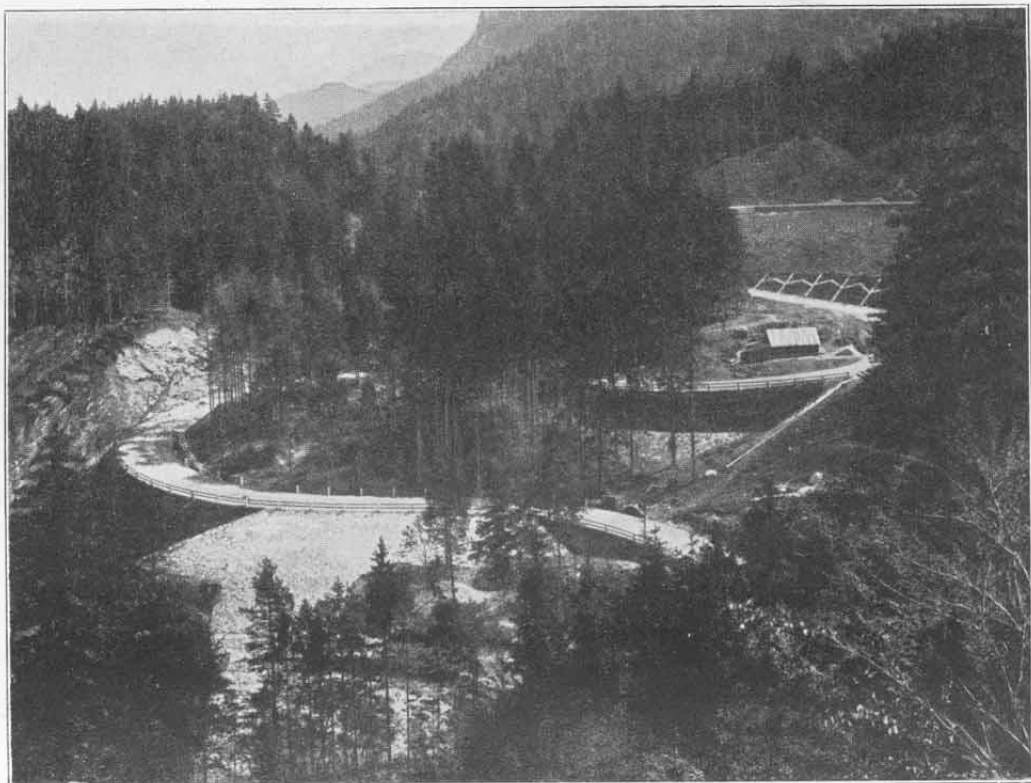
Neue Kesselbergstraße, erbaut 1893—1897. (Aufgen. von F. Kreuter.)
