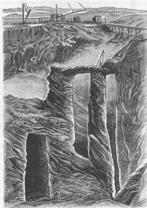
Eisensäulen. Port Henry Mine 21. (N. Y.)
