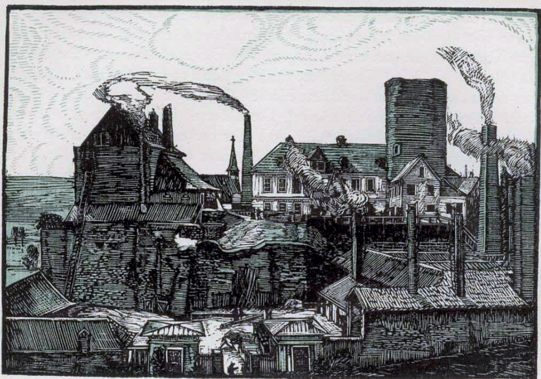
Abb. 5. Blick auf die Mechanische Werkstätte. Nach einem alten Ölgemälde im Besitz von H. Kamp-Berlin.
