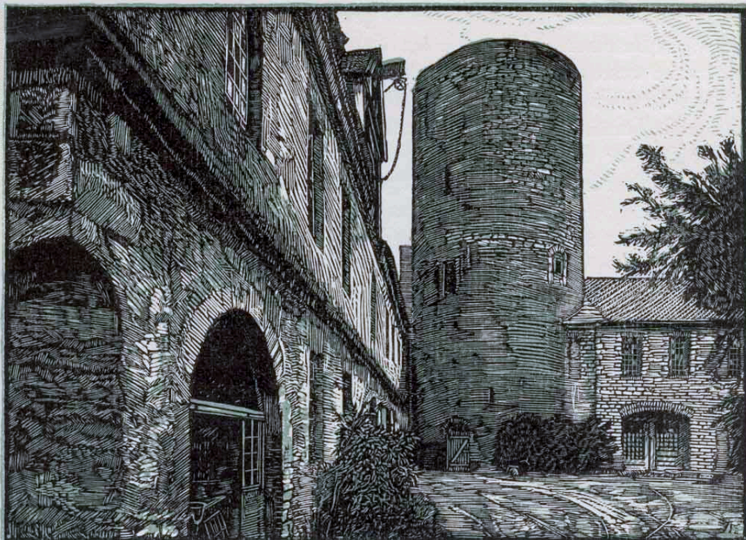
Abb. 6. Blick in den Innenhof der Mechanischen Werkstätte.
