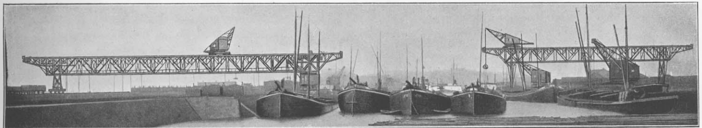
Figur 154. Hafen Walsum: Ansicht des Hafenbeckens.
