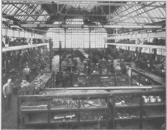
Galerie: Bearbeitung von Steuerungsteilen.
