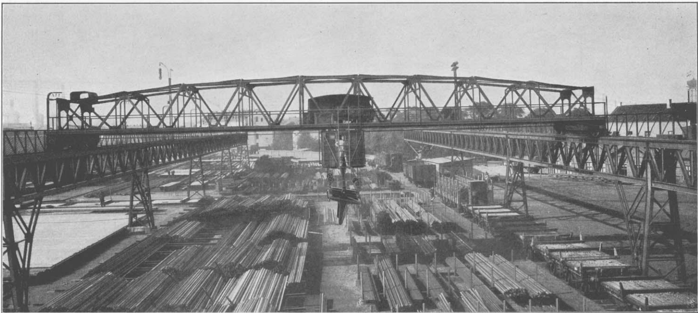
Figur 88. Grubenschienenlager mit Verladekran.
