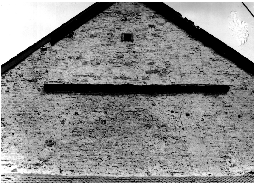
Abb. 17: Schloss Burg, Westgiebel der Martinuskirche um 1960. Im romanischen Mauerwerk sind oben rechts ein ehemaliger Zugang und unterhalb des Balkens zwei zugesetzte Blendbögen zu erkennen, rechts ist ungleichmäßig abgearbeitetes Mauerwerk. Aufnahme: Pfarrarchiv St. Martin
