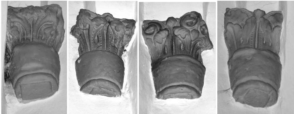
Abb. 20: Schloss Burg, St. Martinuskirche, Blick in das Apsisgewölbe des 17. Jahrhunderts Unten: die darin als Gewölbekonsolen eingebauten romanischen Kapitelle. Aufnahmen der Verfasser 2010
