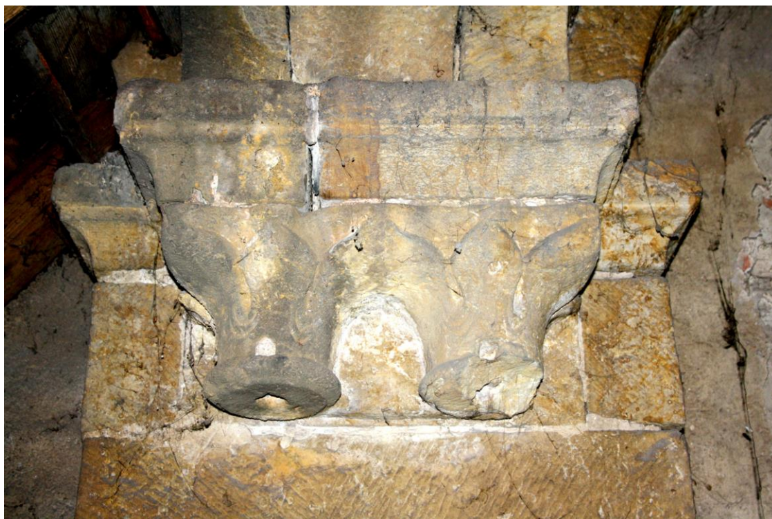
Marienfeld, Westfassade. Doppelkapitell von einem Blindbogen mit sichtbaren Löchern zur Verbleiung der eingestellten Säulen. Foto: Andreas Sassen 2017.
