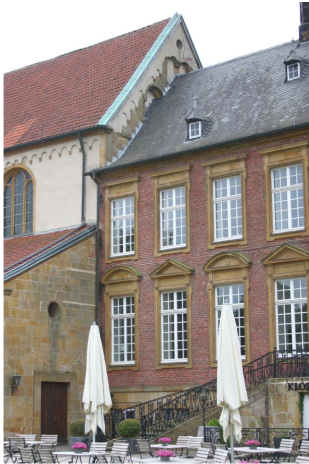
Abb. 1: Marienfeld. Die Verbindungsstelle der Kirchen-Westseite mit dem barocken Abteigebäude. Foto: Andreas Sassen 2018.
