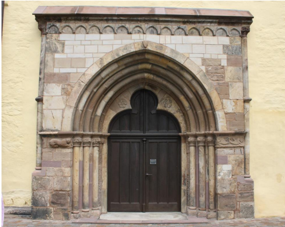
Abb. 57: Lemgo, Nicolaikirche. Das um 1235 entstandene Nordportal der Stadtpfarrkirche. Foto Andreas Sassen 2017.
