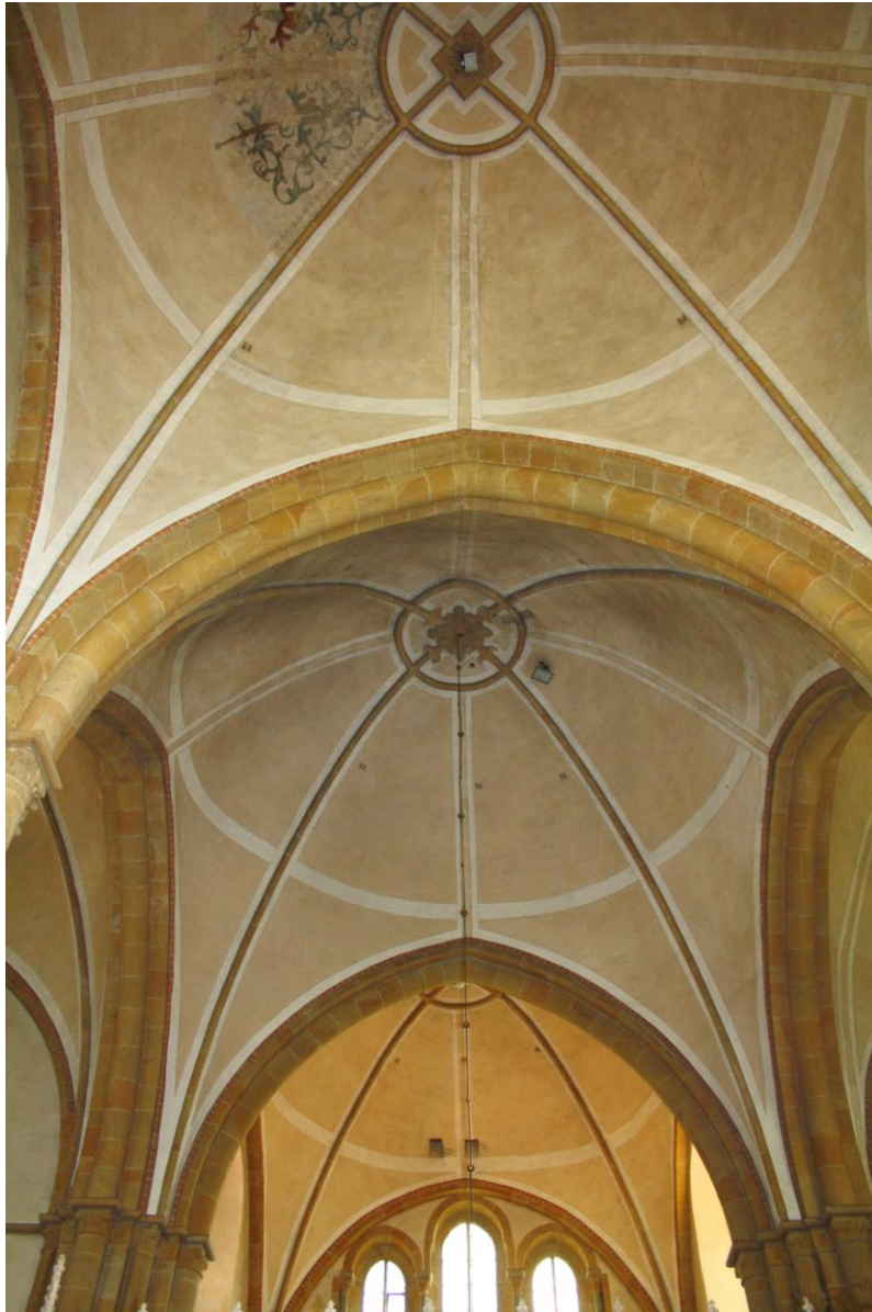
Abb. 16: Kloster Marienfeld. Blick in die Domikalgewölbe von Querschiff und Vierung. Foto: Andreas Sassen 2015.
