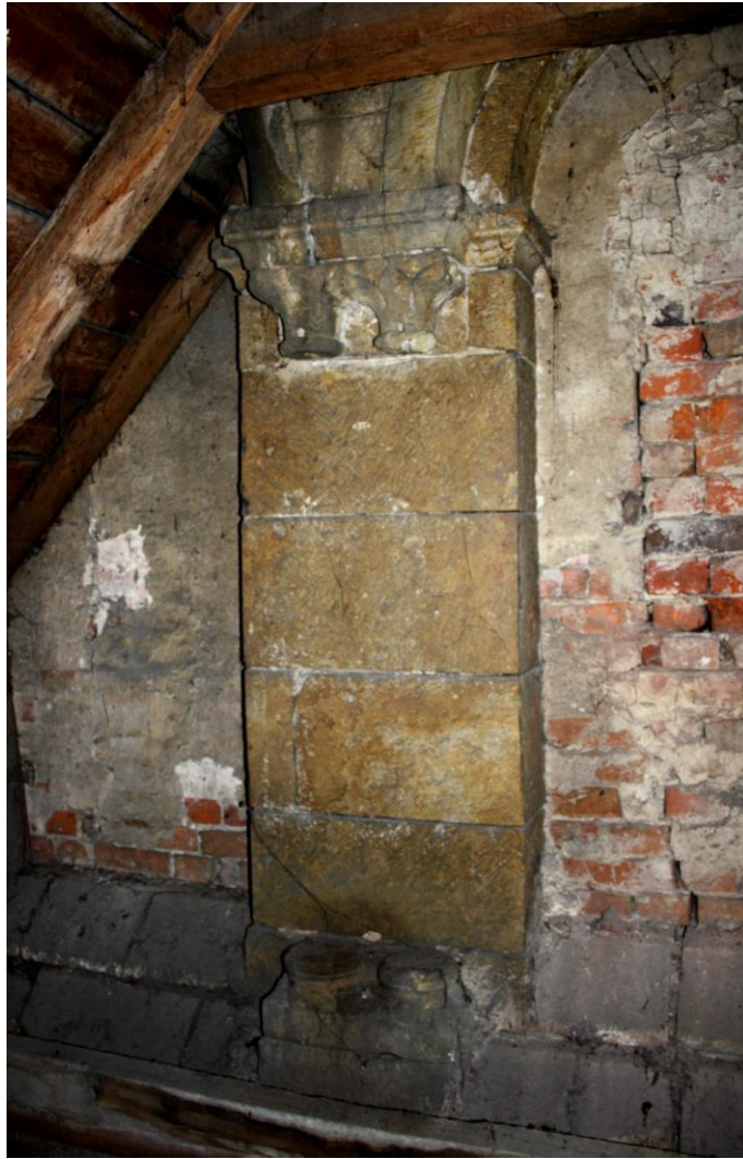
Abb. 7: Kloster Marienfeld. Blendbogen-Wandpfeiler mit den Resten der doppelten Säulenstellung. Die Kapitelle und Basen sind noch vorhanden, die beiden Säulen aber herausgebrochen. Foto: Andreas Sassen 2017.
